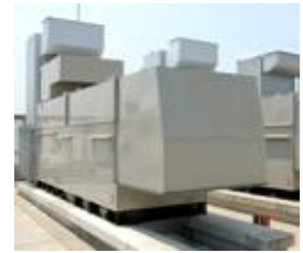
自家発電装置
